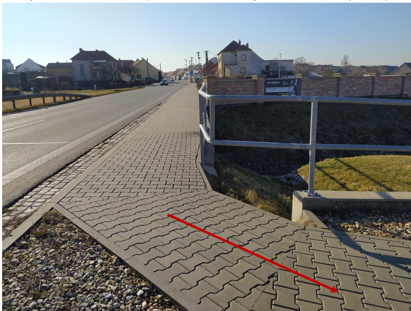
Obr. 3 Stávající komunikace pro pěší - Sjezd S1, staničení 0,000 km
